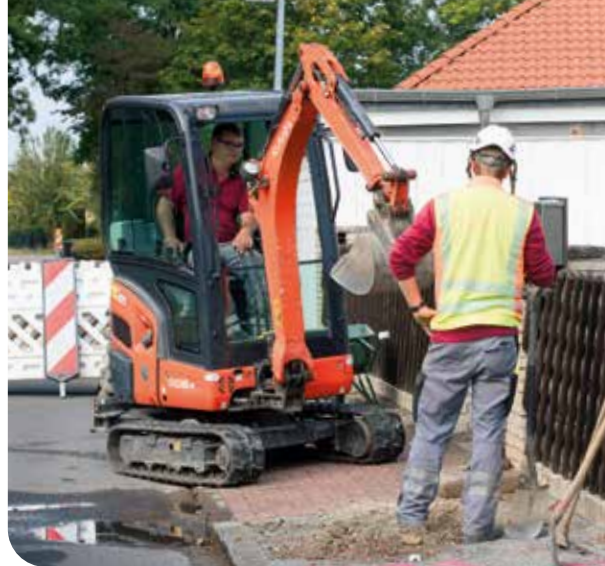
Für die Arbeiten an den Straßen im Stadtgebiet Sehnde ist jetzt das Tiefbau-Team der Stadtwerke Sehnde zuständig.
