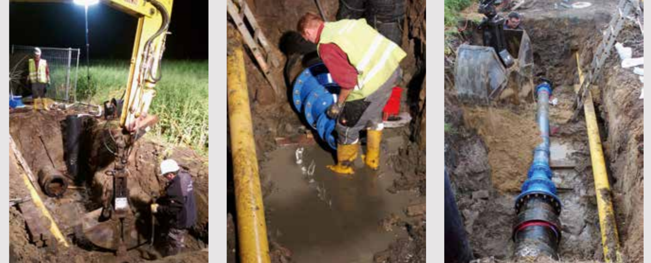
Ein Kraftakt: das nächtliche Einbauen der Reduzierungsstücke.
